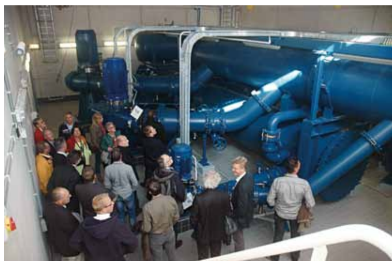
Naast een rondleiding door het duingebied was er ook een rondleiding langs de installaties.
