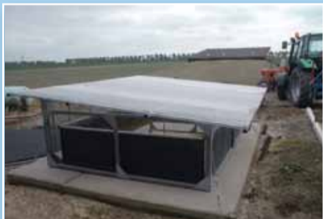
De opvang en verwerking van restanten van gewasbeschermingsmiddelen vallen onder de pijler Verantwoord. Hier de Phytobac (boven) en de HélioSec.
